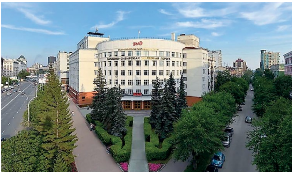
Управление Западно-Сибирской (бывшей Томской) железной дороги на Вокзальной магистрали, 14 (совместно с архитектором Венгеровым). Единственное в городе здание с круглым фасадом, первое, обозначившее будущую Вокзальную магистраль. Правое крыло было предназначено для квартир руководства дороги.
