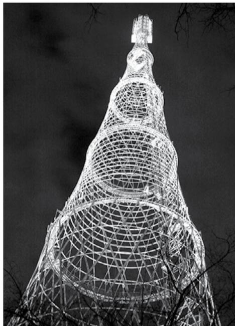
**Гиперболическая сетчатая башня высотой 160 м на Шаболовке, 1919–1922 гг.**
