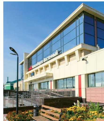
Капитальный ремонт вокзала Новосибирск Восточный
