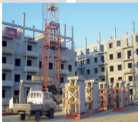
Строительство жилых домов
