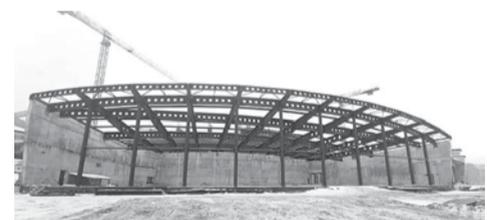
на объекте идет монтаж металлоконструкций непосредственно многофункциональной ледовой арены и тренировочной арены, бетонирование монолитных вертикальных конструкций и перекрытий, завершается бетонирование отдельно стоящих ростерков. Сегодня на стройплощадке трудятся более 300 специалистов.
