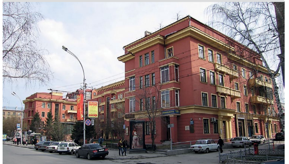
Жилой дом Облплана на Красном проспекте, 56 (1939 г.), памятник архитектуры. Фасад сильно испорчен остеклением балконов.
