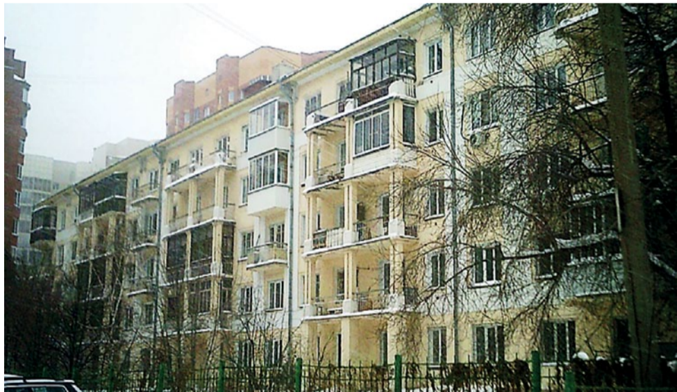
Профессорский корпус Сибстрина (1933 г.). Фасад испорчен остеклением балконов. Это здание вместе с учебным корпусом Н.С. Кузьмин запроектировал ещё в Томске, и ко времени переезда Сибстрина в Новосибирск оба они были построены. В 1953-м г. был пристроен (по проекту других авторов) новый учебный корпус в стиле неоклассицизма, а старая часть стала его правым крылом. Фасад старой части был радикально изменен с целью гармонизации с новой частью, но, к сожалению, единства так и не получилось.
