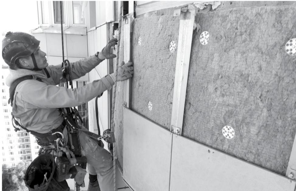
дят для крепления теплоизоляции не только в НФС, но и в системах штукатурного фасада и предназначены для установки во всех видах оснований: бетон, пустотелый и полнотелый кирпич, керамические блоки, газобетон и др., без ограничения по высоте. В зависимости от материала основания и нагрузки такие анкеры можно устанавливать на разную глубину.
